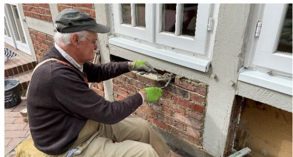
Arbeit an der frischen Luft: Hans-Dieter Gerken beim Austausch des Fundamentbalkens, bei dem auch seine Maurerqualitäten zum Einsatz kommen.
