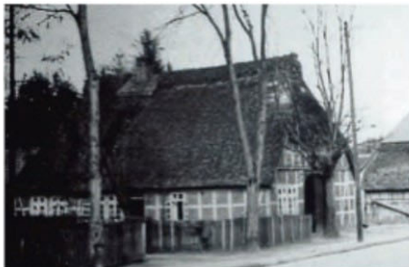
Damals war das Dach noch mit Reet gedeckt: Das Trömen-Haus, festgehalten auf einer historischen Aufnahme um das Jahr 1956 herum.
