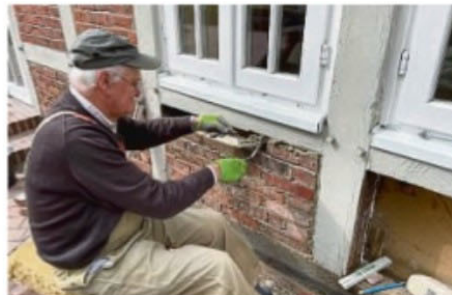
Arbeit an der frischen Luft: Hans-Dieter Gerken beim Austausch des Fundamentbalkens, bei dem auch seine Maurerqualitäten zum Einsatz kommen.
